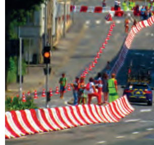
• balisage de chantier
