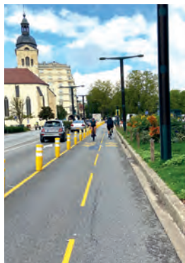
146 Sécuriser et baliser pour protéger la vie
